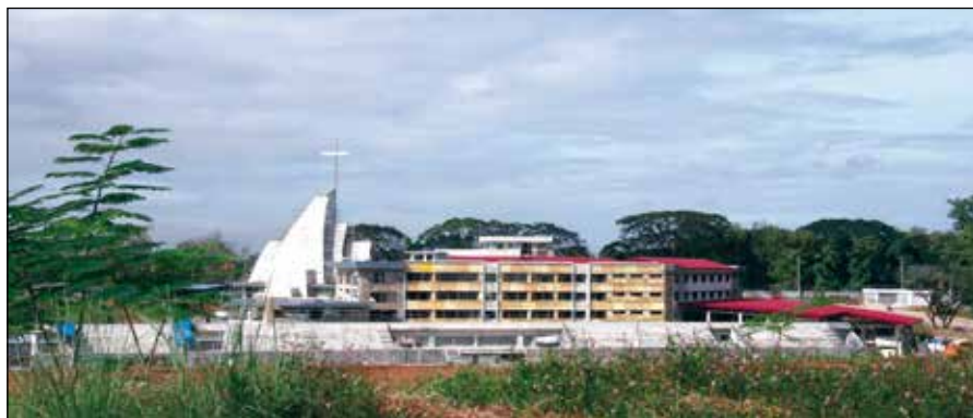
El Colegio S. Agustín de Bulacán, en construcción, en 2014.
